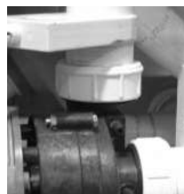
Vanne guillotine et raccord-union de la pompe
