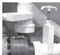
Vanne guillotine et raccord-union de la pompe
