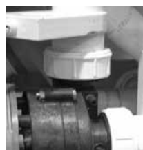
Vanne guillotine et raccord-union de la pompe
